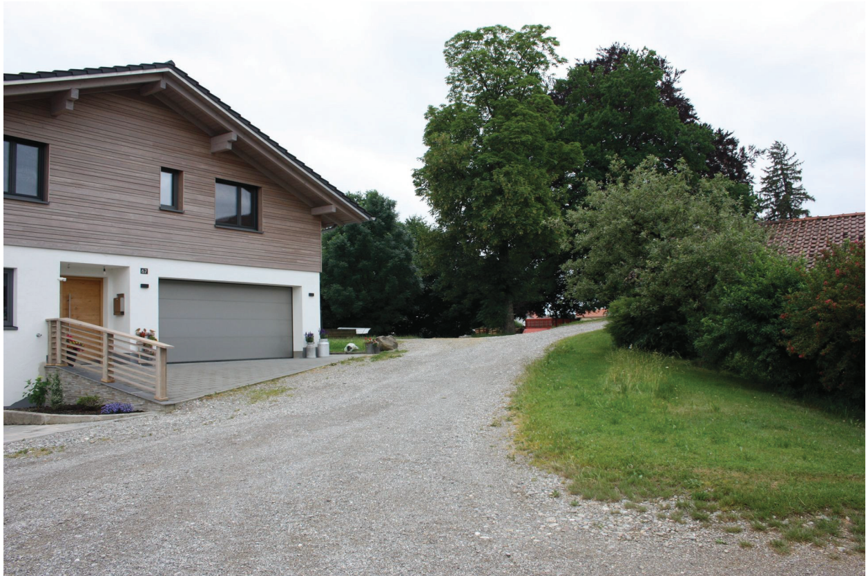
Abbildung 7: Haus an der Mindelheimer Straße 67, welches im Geltungsbereich liegt und durch die gegenständliche Planung gesichert werden soll, fotografiert aus nördlicher Richtung. Im Hintergrund die rückwärtige Bebauung im Plangebiet.
