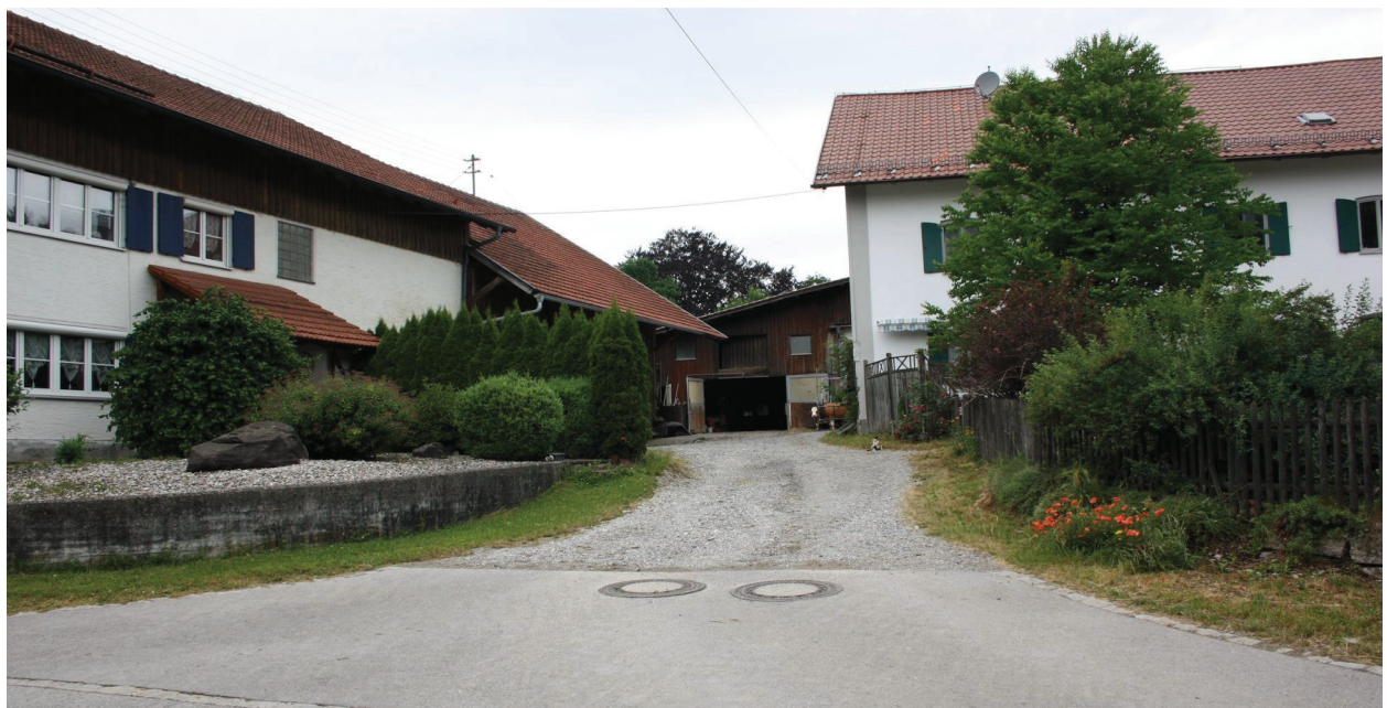
Abbildung 6: Haus am Eisbachweg 4 mit rückwärtigem Teil, der zum Abbruch vorgesehen ist (linke Bildhälfte), sowie ehemalige landwirtschaftliche Hofstelle Mindelheimer Straße 63 mit rückwärtig gelegenen Stallgebäuden (rechte Bildhälfte)
