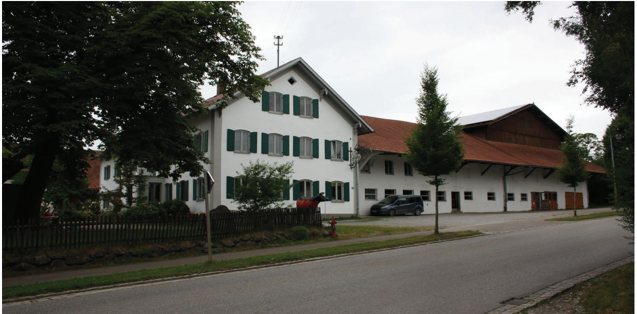
Abbildung 3: Ehemalige Hofstelle mit der Hausnummer Mindelheimer Straße 64, von Osten aus fotografiert
