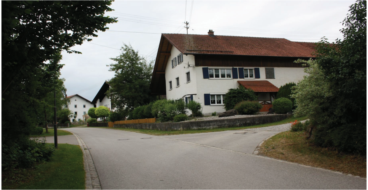
Abbildung 5: Haus am Eisbachweg 4, die vordere, linke Hälfte bleibt erhalten, die hintere ist zum Abbruch vorgesehen
